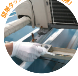
エアコン室外機標準色でタッチアップ補修 ※サビがひどい場合は事前にサビキラーPROを塗布することでより防錆効果は高くなります。
