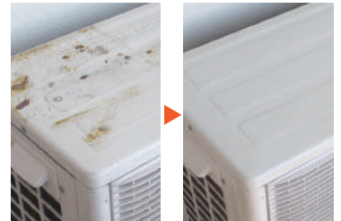
エアコン室外機標準色でタッチアップ補修 ※サビがひどい場合は事前にサビキラーPROを塗布することでより防錆効果は高くなります。
