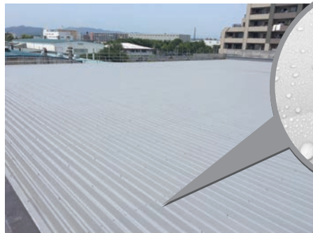
②屋根を全面施工。防錆効果だけでなく、撥水・防音効果も得られ雨漏りもストップ。
